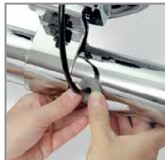
Läpivienti tiivistetään läpivientitiivisteellä
