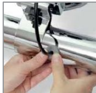
Läpivienti tiivistetään läpivientitiivisteellä
