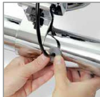
Läpivienti tiivistetään läpivientitiivisteellä
